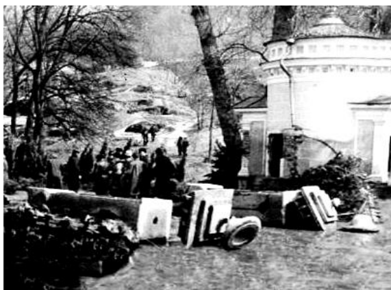
Рис. 1. Зруйнований Головний вхід
